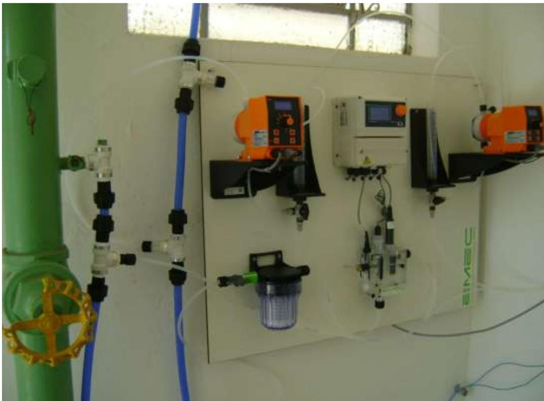
**Figura nº 2: Painel com as bombas dosadoras, controlador, filtro e porta sondas**
